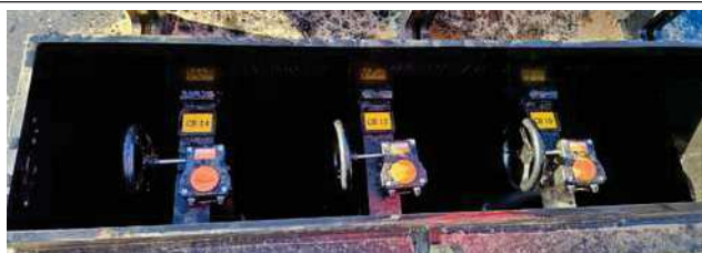
Chambre à vannes (seul CB10 en rejet de lixiviats)
